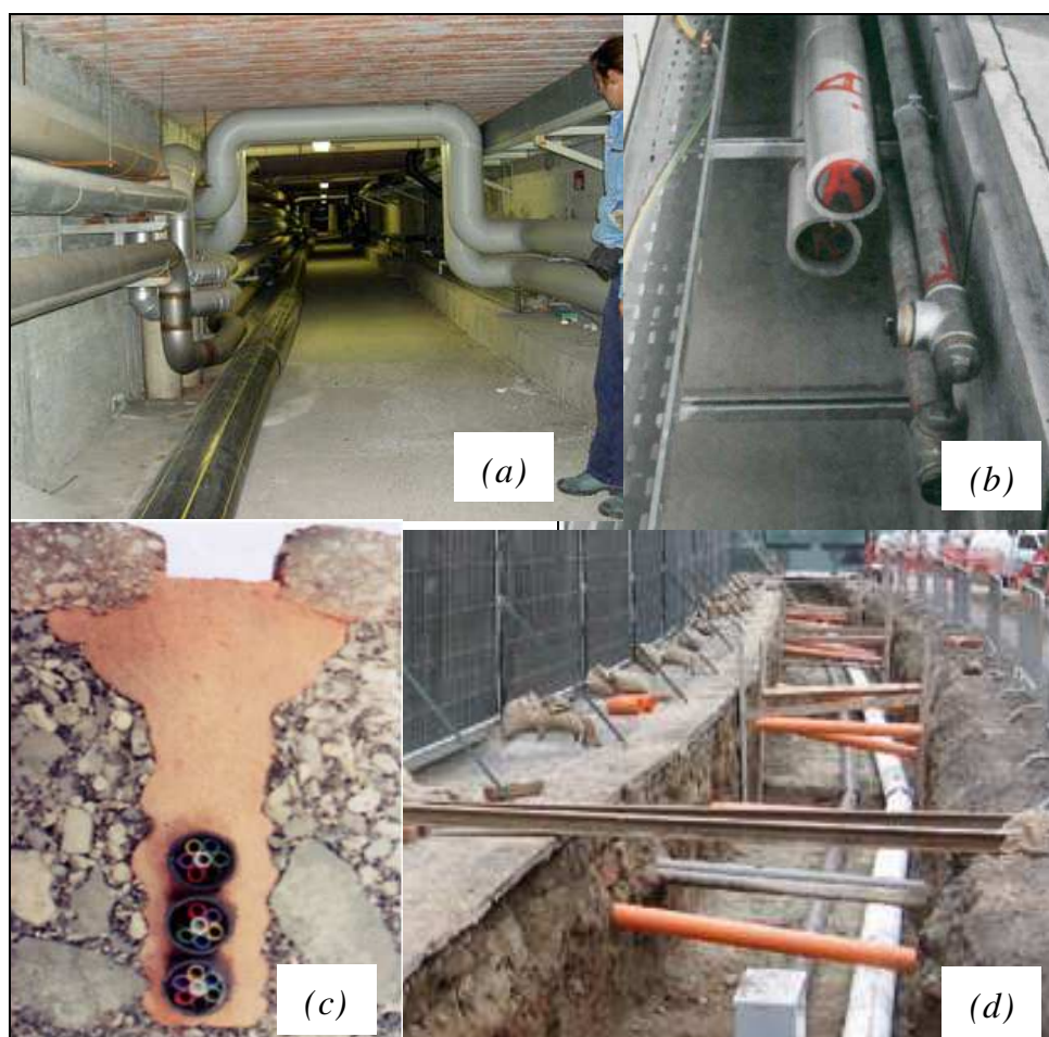
Figura 1 – Galleria polifunzionale(a), cunicolo tecnologico (b), polifora (c) e trincea (d) (fonte: Regione Lombardia - Osservatorio Reti e Servizi di Pubblica Utilità)
